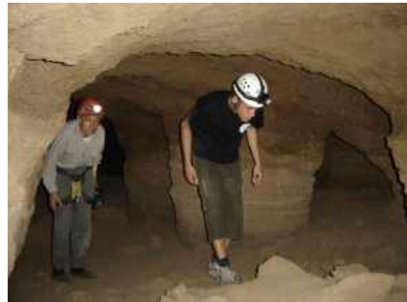
Lavayén y Mendy dentro de una de las galerías, obsérvese los pilares que funcionan de sostén.
