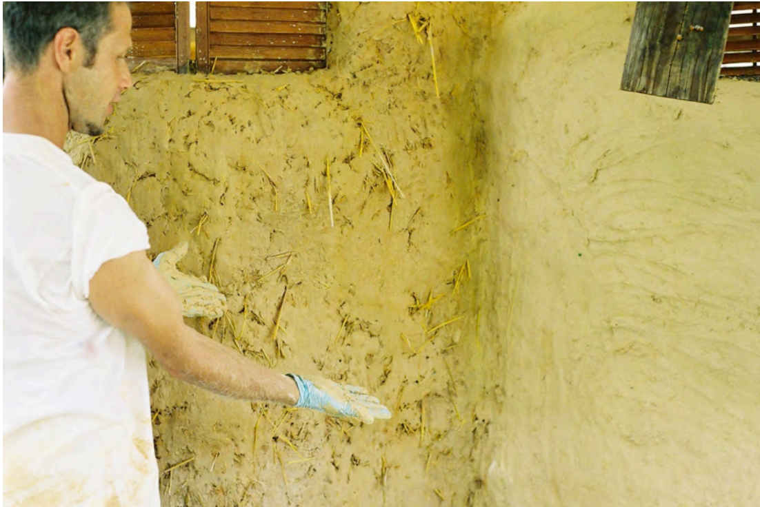
Fig. 28. Scratch coat: Final coat
