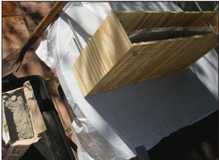
Fig. 86 Concrete form work before the pour
