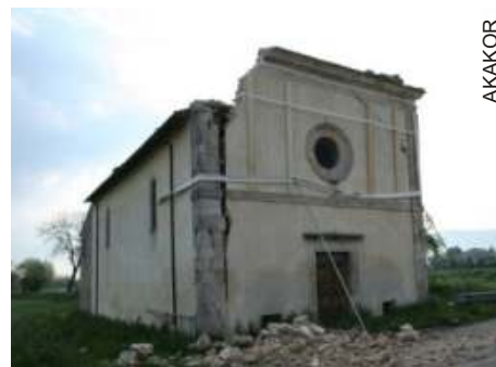
Construções históricas também foram atingidas
